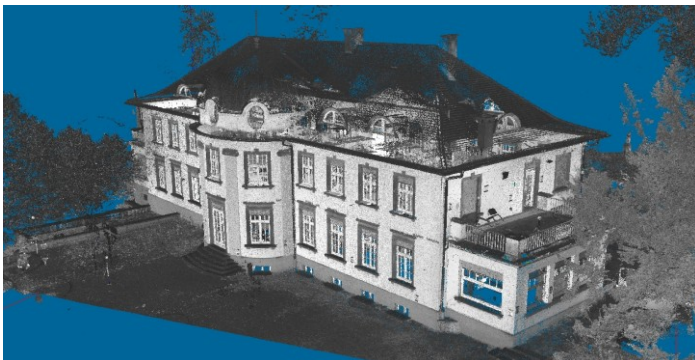
Laserscan-„Punktwolke“ eines Gebäudes – jeder Punkt ist ein gemessener Punkt mit X-, Y- und Z-Koordinate und vermessungstechnischer Genauigkeit!
